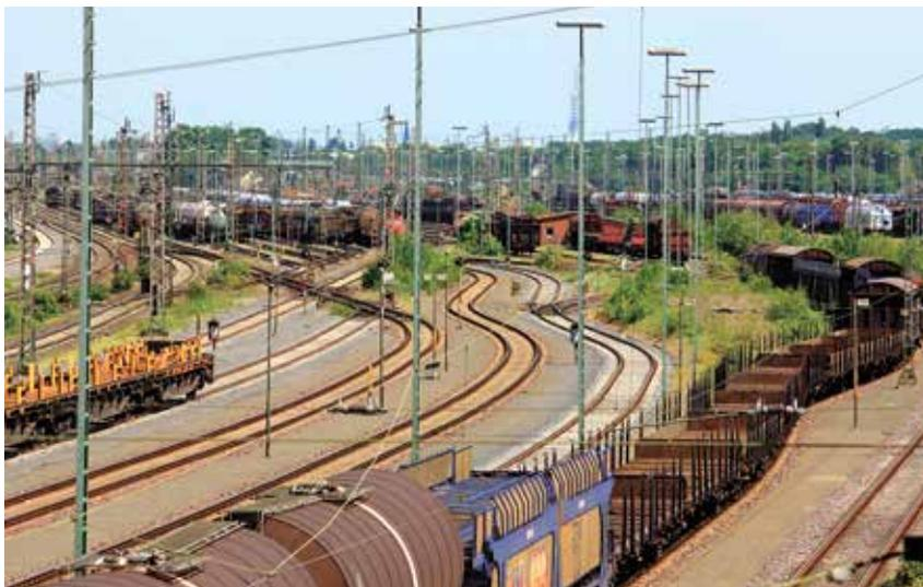
„Seelze Rbf“ ist als Drehscheibe im Schienengüterverkehr eine wichtige Zugbildungsanlage mit täglich rund 5000 rangierten Güterwagen
